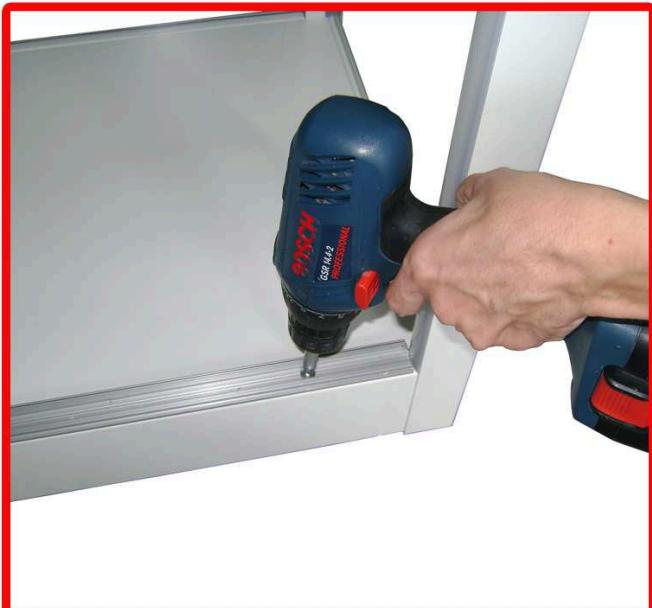
**Fissare il binario superiore del kit scorrevoli a filo con il cappello metallico mediante le viti auto perforanti in dotazione.**
